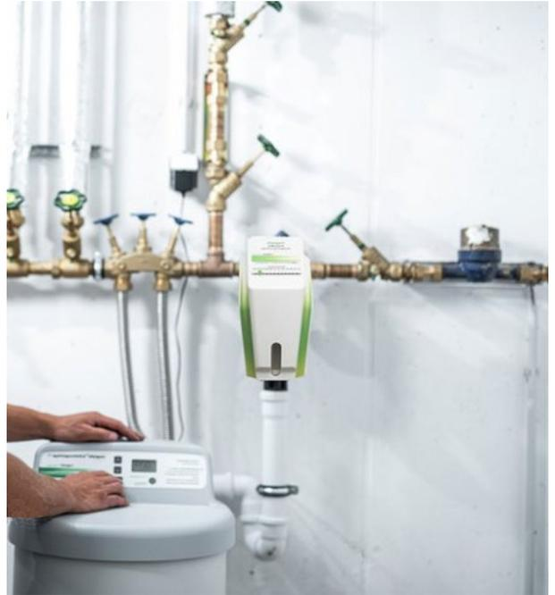
*Eine durch TWB fachgerecht installierte und gewartete Trinkwasser-Enthärtungsanlage sorgt für Kalkschutz im ganzen Haus und gibt die wohlthuende Sicherheit, dass Kalk keine Schäden mehr anrichten kann.*
