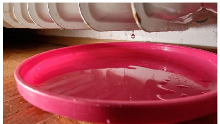
Nicht aufbereitetes Heizungswasser führt dazu, dass Heizkörper schnell korrodieren und undicht werden.
